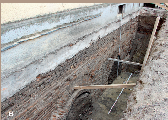
Priestor plánovanej prístavby východného kídla kláštora s dodatočne prístavaným schodiskom do pivničného priestoru (A), vynášacie oblúky severnej steny južného kídla (B) a murovaný objekt z neskorého stredoveku (C).
