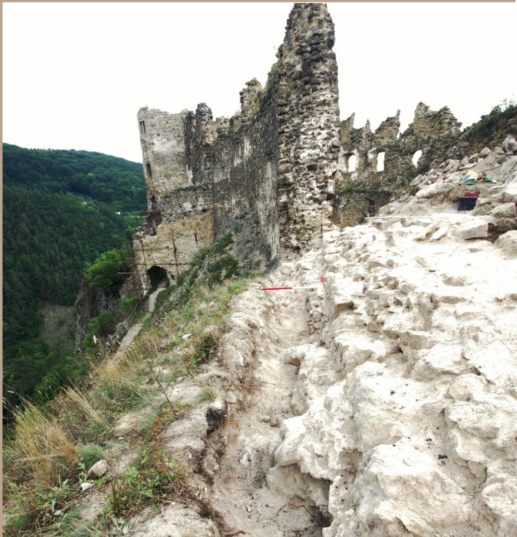
Odkrývanie južného opevnenia, pohľad od východu
