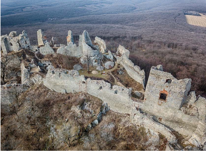
Letecký pohľad na hrad Gýmeš.
