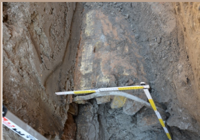
Detail na klenbu kanalizácie
