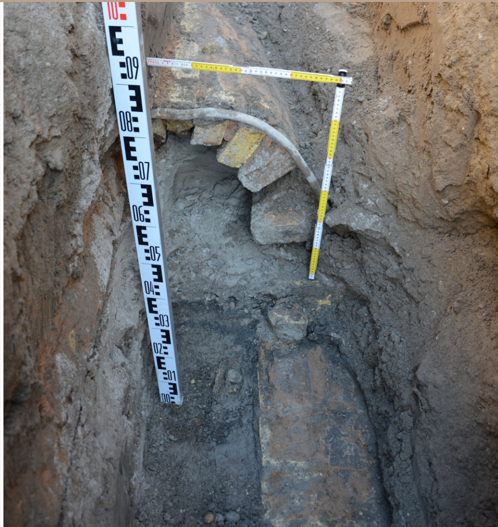
Detailný pohľad na tehlovú kanalizáciu na Ulici Biskupa Királya
