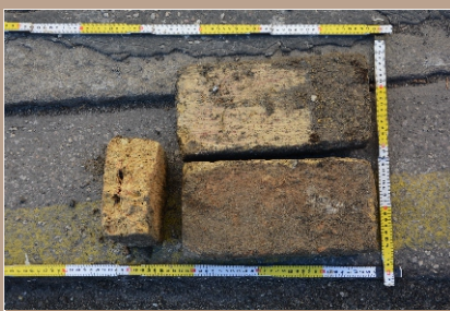
Stavebný materiál - nekokované tehly
