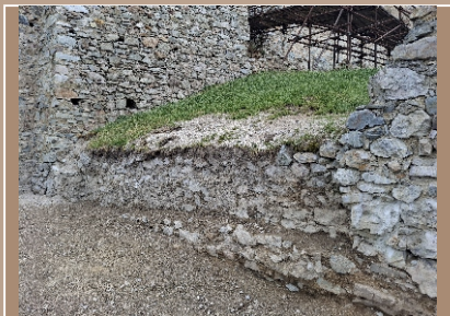
Hrad Hrušov, sonda 13E/2025, pohľad na hradbu z juhu po obnovu v roku 1928, odstúpenie o 10 cm
