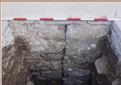
Pohľad z exteriéru na SZ nárožie románskej lode a murivo renesančnej prístavby.
