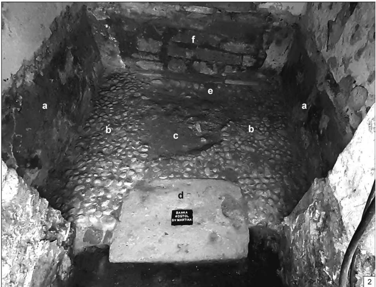
Obr. 69. Banka (Kostol sv. Martina). 1 – pôdorys kostola s vyznačením hlavných stavebných fáz a situovaním sondy; 2 – pohľad do interiéru podvežia po ukončení výskumu (legenda: a – odkryté steny podvežia; b – dlažba z obliakov; c – porušená časť dlažby; d – kamenná platňa prahu; e – kamenný prah portálu lode; f – zámurovka portálu). (Samuel, 110).
