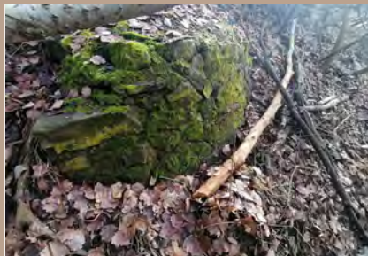
Kamenné základy historickej mostovej konštrukcie v Bajči
