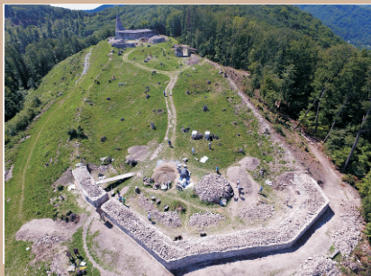
Letecký pohľad na severnú líniu opevnenia Dolného hradu
