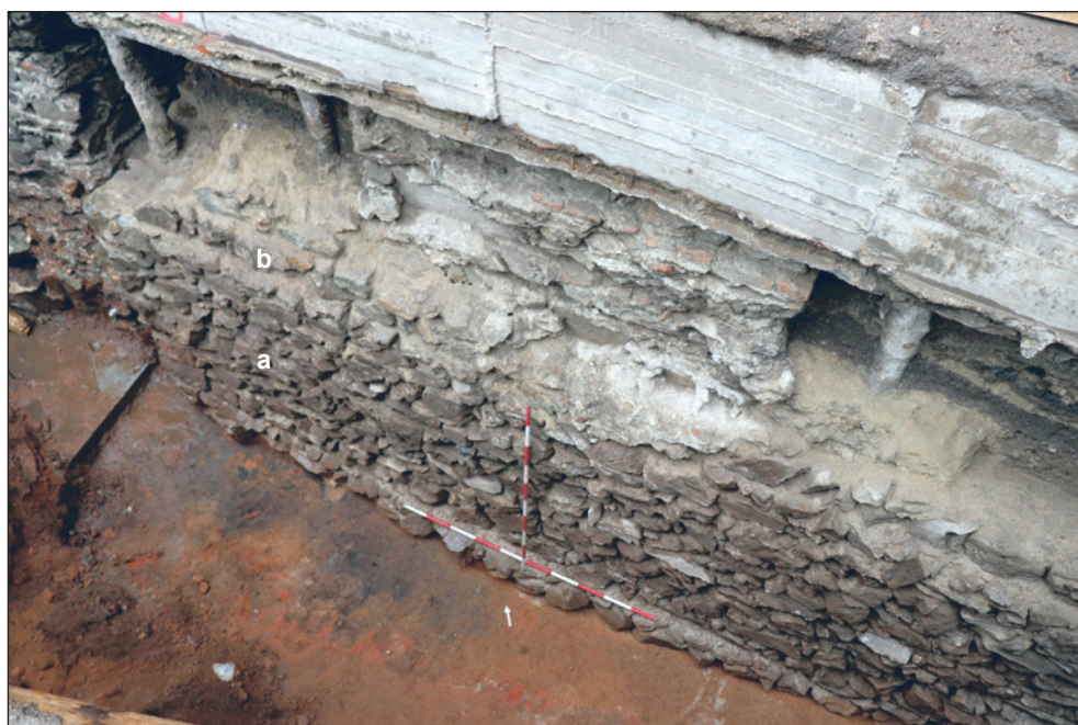
Obr. 10. Bratislava, hrad. Pohľad zhora na základové (a) a nadzákladové (b) murivo juhozápadného múru románskej veže (foto M. Samuel).
