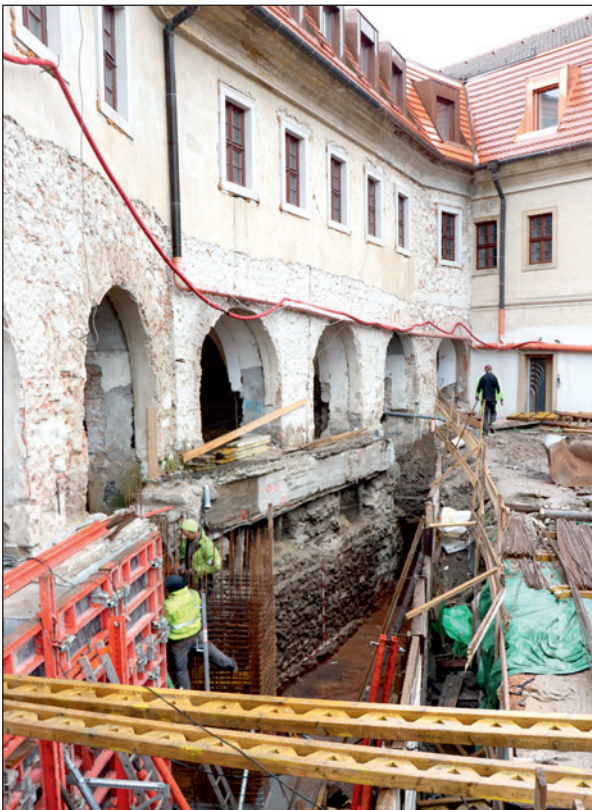
Obr. 2. Bratislava, hrad. Stavebná jama vyhlbená pre sanovanie základov východného úseku budovy na severných hradbách. Pod dvojicou prostredných arkád a ich základových pilierov vidieť v plnej výške zachované základové murivo juhozápadného múru románskej veže (foto M. Samuel).
