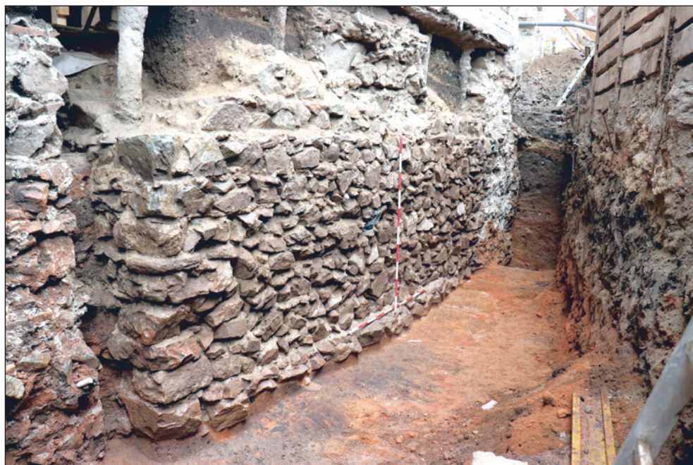
Obr. 9. Bratislava, hrad. Pohľad zo sondy na nádvorí na odkryté západné nárožie a líce základového muriva románskej veže (foto M. Samuel).
