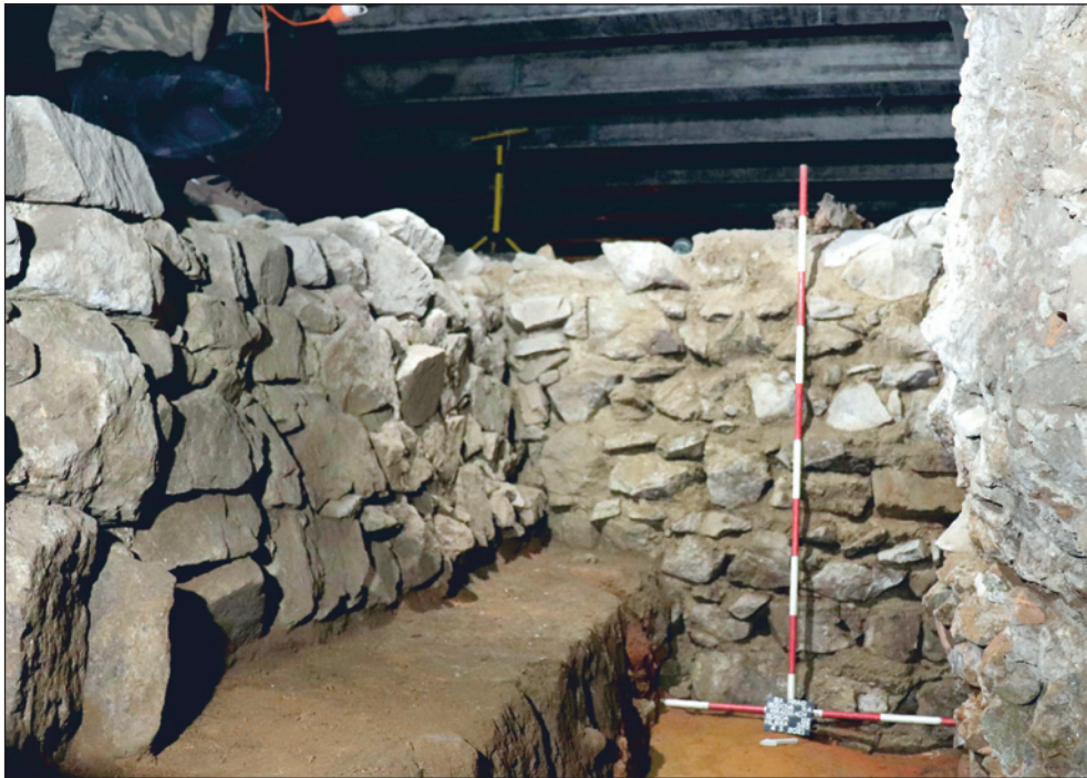
Obr. 7. Bratislava, hrad. Najlepšie zachovaný úsek vnútorného líca románskej hradby (vľavo) a murivo románskej veže (foto M. Samuel).
