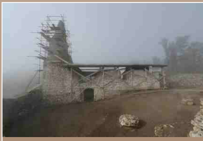
Východná stena veže po obnove
