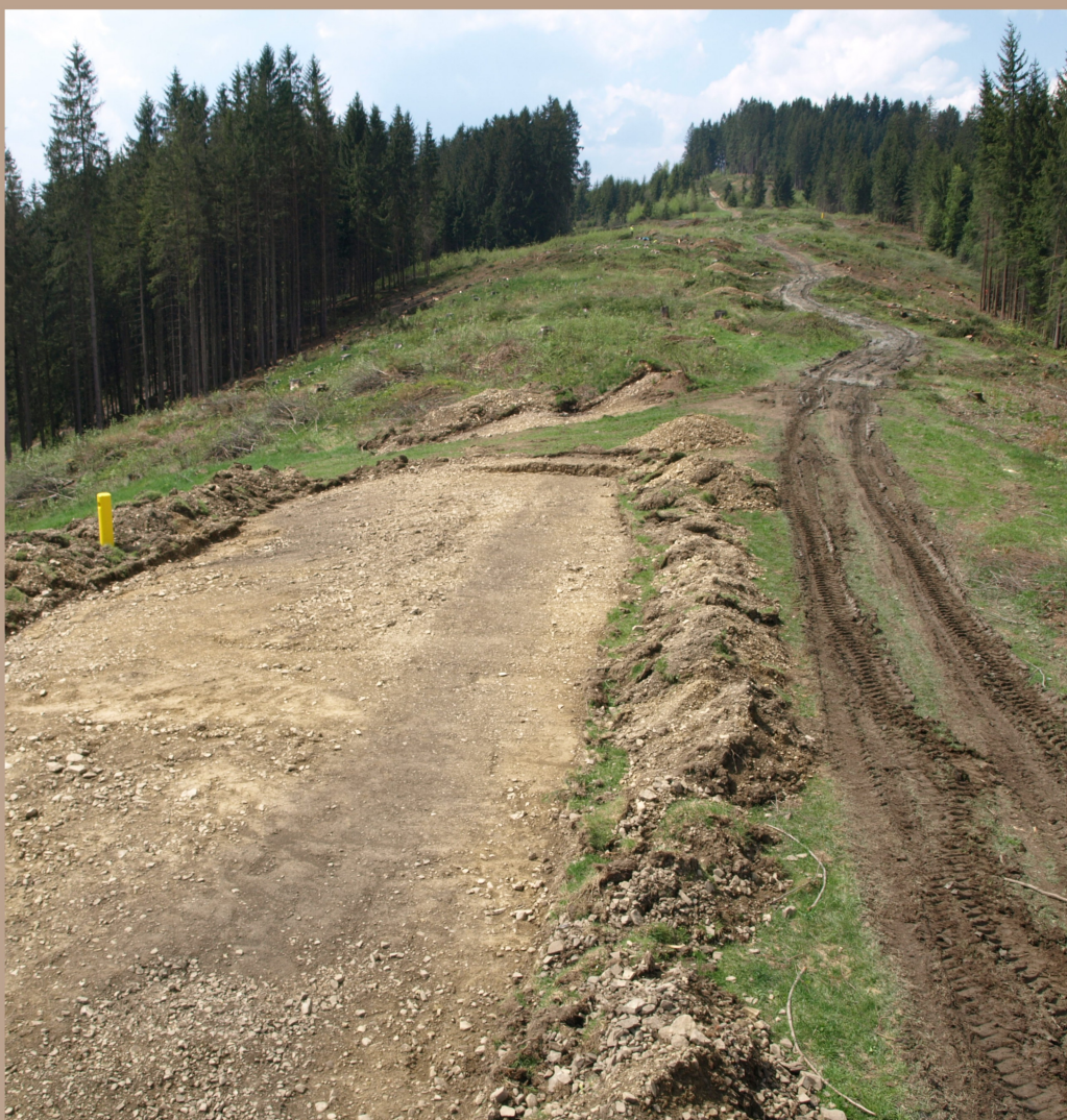
Úsek pevnostného systému západne od Reduty 4 dotknutý stavebnou činnosťou (v popredí zásyp priekopy)
