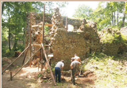
Výkopové práce pri Kapitánovom dome
