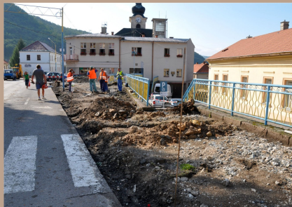
práce na Námestí slobody
