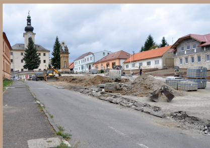
práce na ul. Osvety
