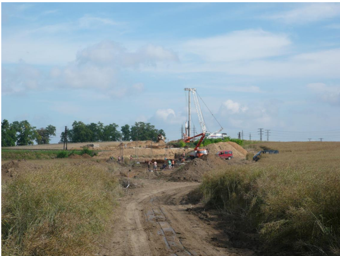
Obr. 4. Pohľad na výskum a stavbu premostenia cez železnicu.
