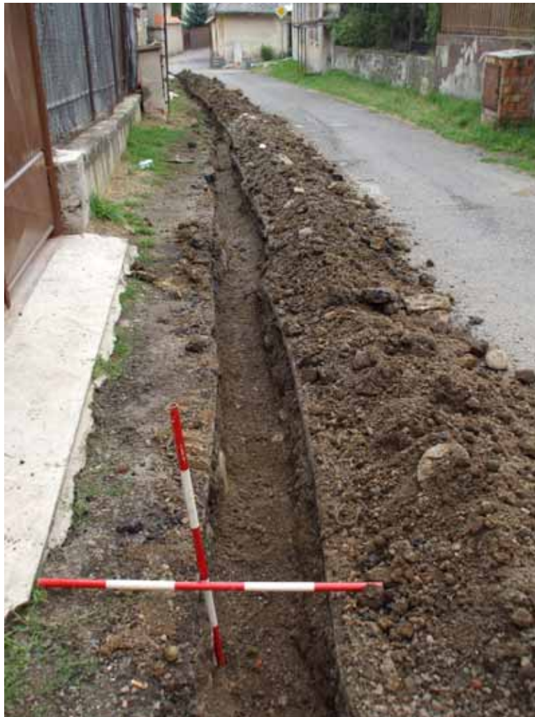
Obr. 02. Krupina, ul. Sládkovičova a Hajdúsky rád. Pohľad na ryhu pre kábel osvetlenia.
