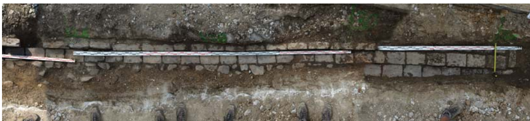
Obr. 01. Banská Bystrica, Obnova STL plynovodu ul. Kapitulská. Odkrytý chodník pôvodnej ul. Novej.
