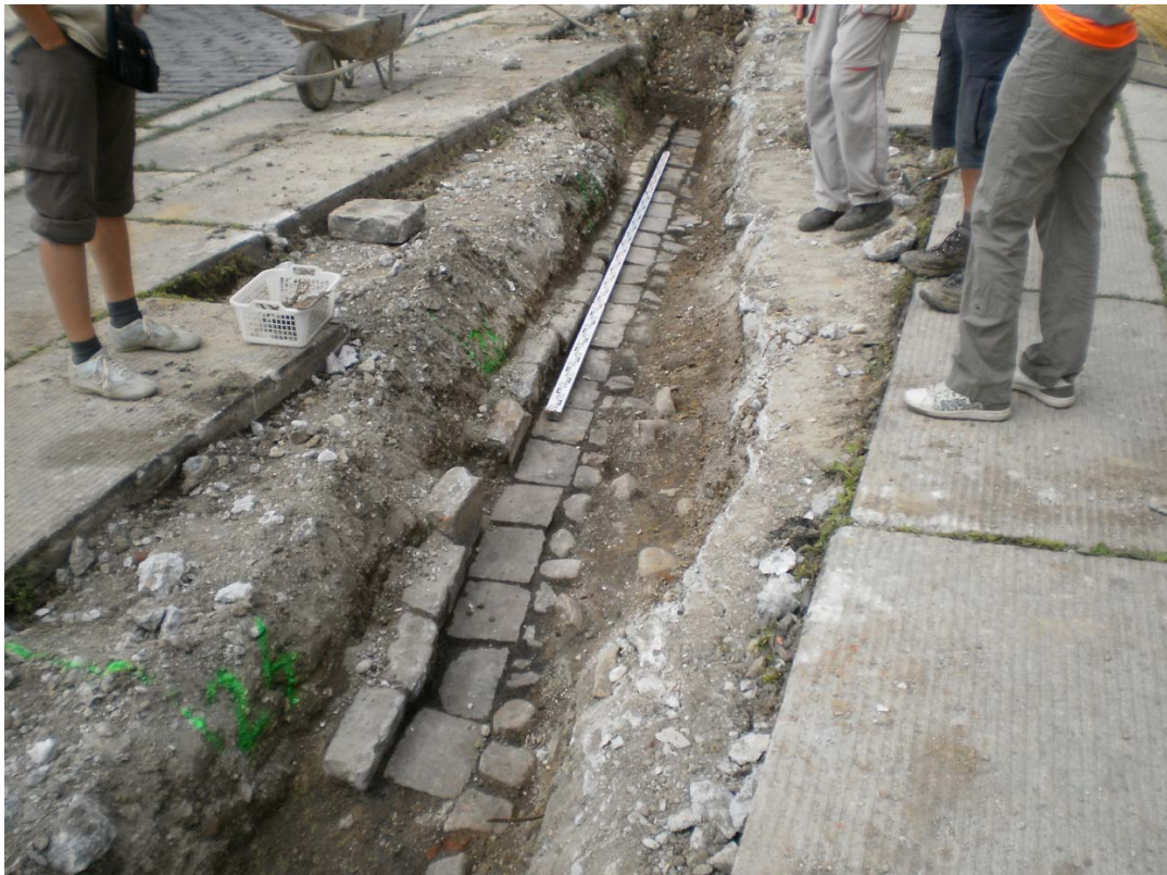
Obr. 02. Banská Bystrica, Obnova STL plynovodu ul. Kapitulská. Odkrytý chodník pôvodnej ul. Novej.
