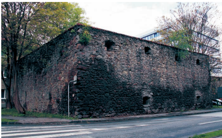
SEVEROVÝCHODNÝ BASTIÓN MESTSKÉHO OPEVNENIA
