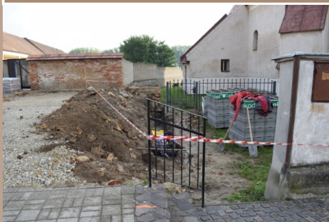
Obr. 2. Líniová stavba - základová ryha oporného múrika plánovaného parkoviska
