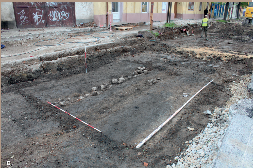
Pohľad na časť zachyteného cintorína v severnej časti ulice, v priestore cesty - plocha I/1 (A) a zistené pozostatky po novovekej ceste v južnej časti ulice - plocha II/1-2 (B).
