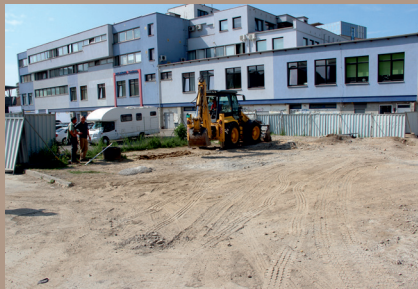
Pohľad na plochu stavby pred začatím stavebných prác
