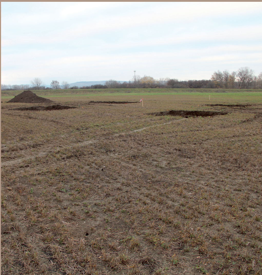
Pohľad na situovanie výkopov pätič podporných bodov stožiaru 21, južne od Dudváhu, západne od obce Siladice
