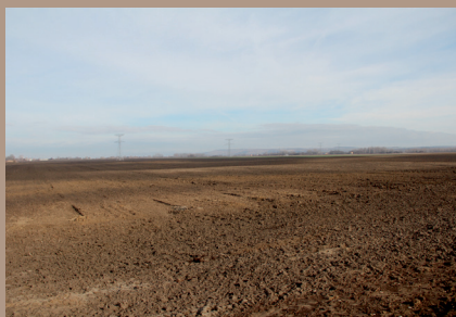
Pohľad na líniu stožiarov 19, 20, 22, 23 a rozostavaný stožiar 21
