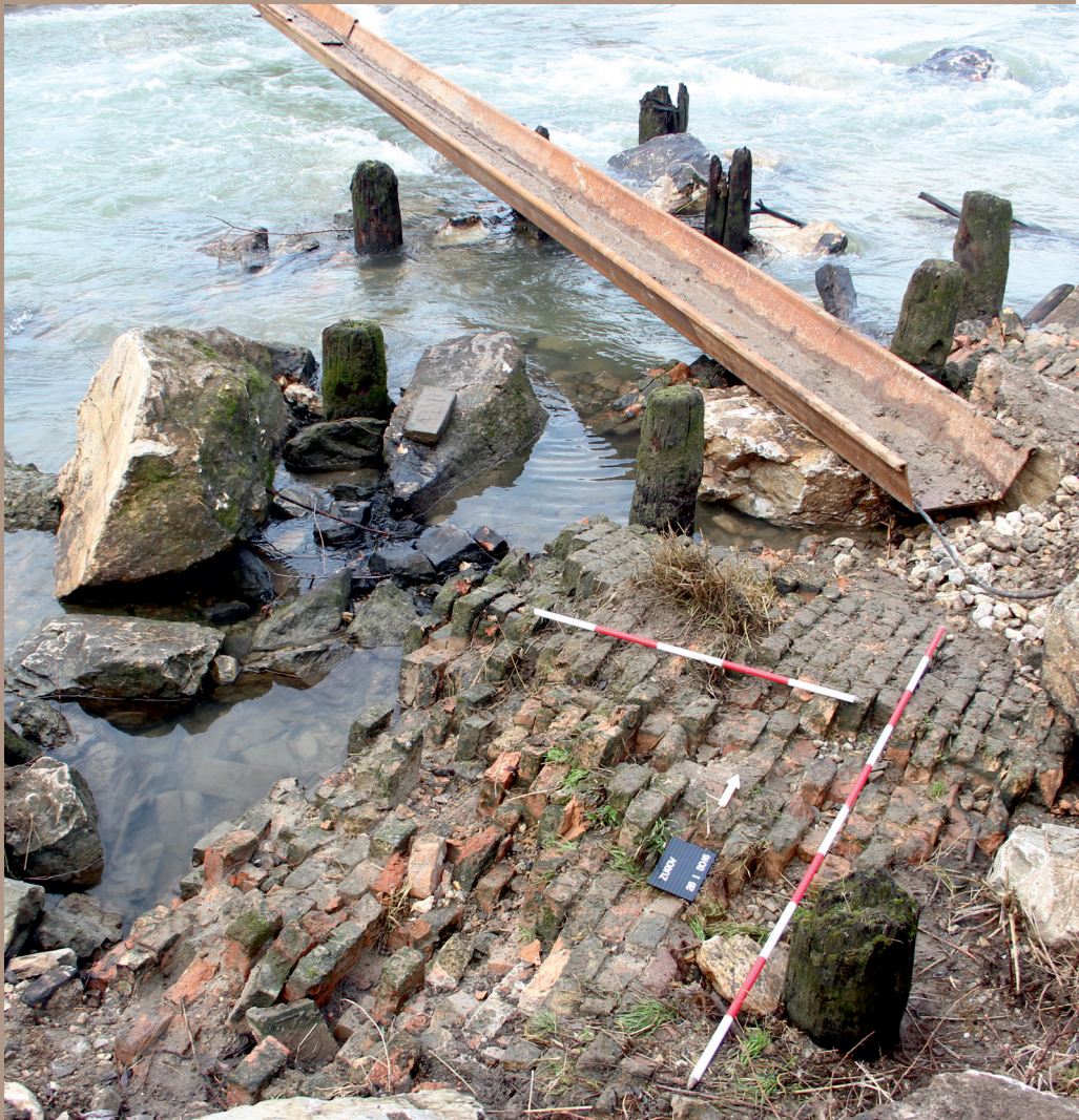
Tehlová konštrukcia a drevené koly (zvyšky mostu - k09) na východnom brehu rieky Nitra
