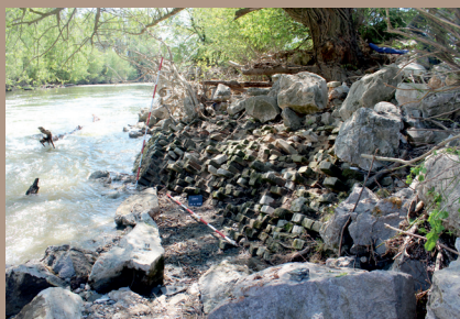
Tehlová konštrukcia (k05) na západnom brehu rieky Nitra
