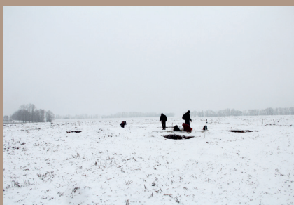
Situovanie výkopov pätiiek podporných bodov (pohľad z východu)
