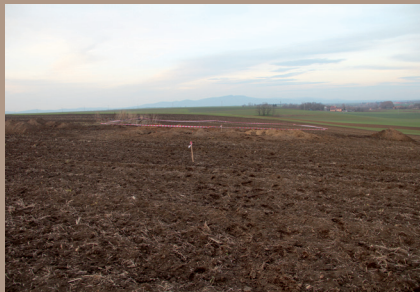
Situovanie výkopov päťok podporných bodov (pohľad z juhu)
