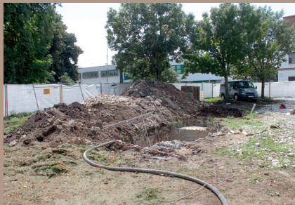
Celkový pohľad na plochu stavby
