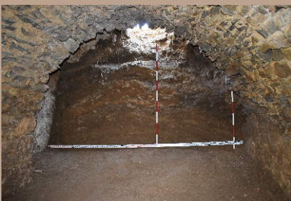
Obr.4. JV bastión, západná kazemata. Severná polovica, zasypaný vstup. (13/A/2020)
