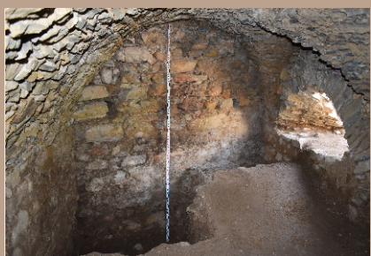
Obr.3. JV bastión, západná kazemata. Južná polovica, zamurovaná strieľňa. (13/A/2020)
