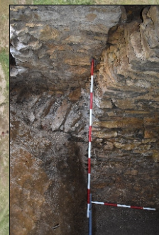
Obr.5. JV bastión, severný okraj. klenba východnej kazematy, mladšia klenba nad nimi. (13/A/2020)
