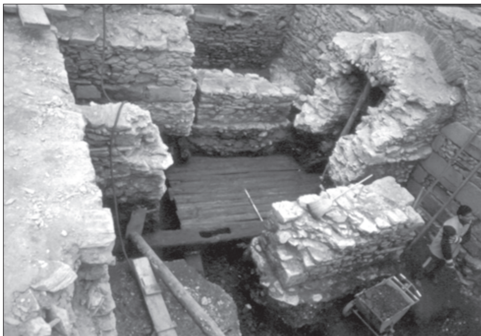
Obr. 18. Košice. Dolná brána. Pohľad na objekt 22, pätky P1 a P2, kanál 8 a časť objektu 1 (od severozápadu).
