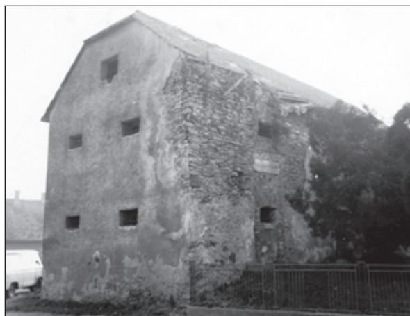
Obr. 3. Zemplín. Pohľad na Župný dom z juhu, pred rekonštrukciou.
