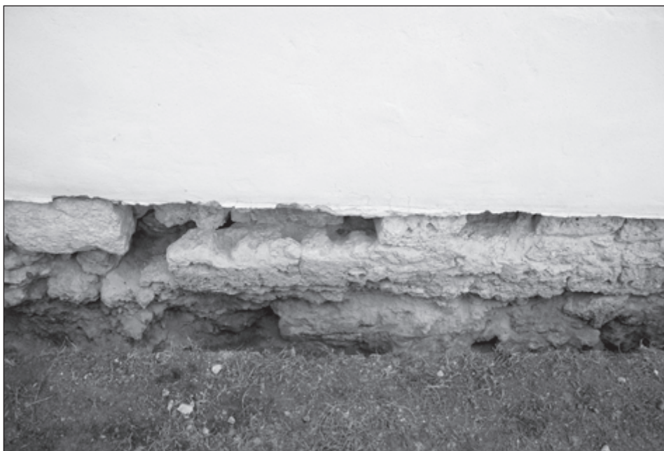
Obr. 13. Hrhov. Kostol sv. Jána Krstiteľa. Murivo pôvodného kostola v miestach južného vstupu.
