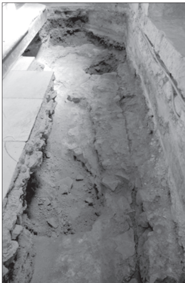
Obr. 7. Turňa nad Bodvou. Kostol Nanebovzatia Panny Márie. Základové murivo pôvodného presbytéria kostola.
