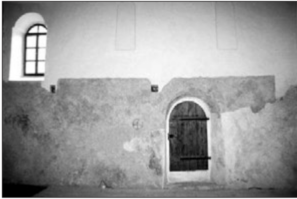
Obr. 8. Pohľad na južnú stenu stredovekej lode po reštaurovaní.
