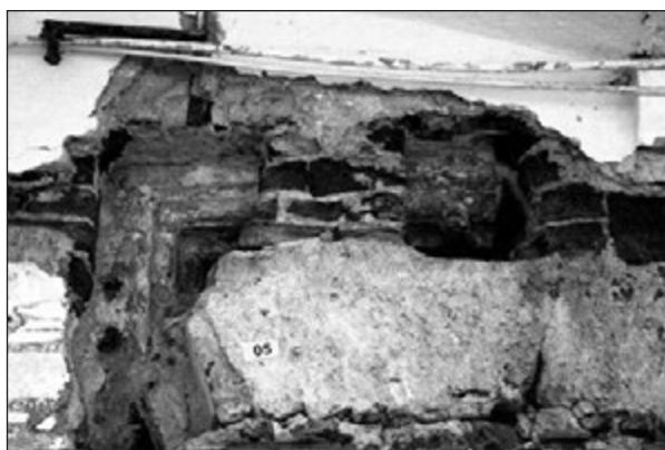
Obr. 12. Fotografia fragmentu hornej časti kamenného rámu gotického okna na západnej strane južného priečelia na prízemí.
