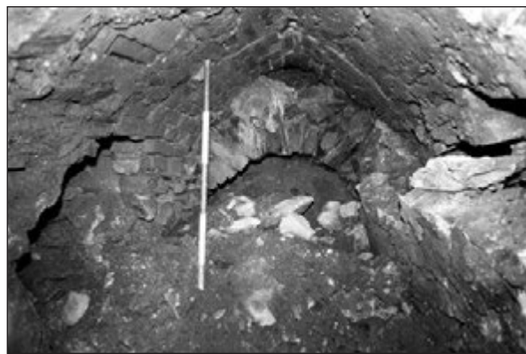
Obr. 14. Tehlou zaklenutý kanalizačný priepust pre kanál 10 vo východnej obvodovej stene mosta (objektu 1) a v pozadí klenba kanála 10 mimo mosta vo vnútornej priekope, od Z.
