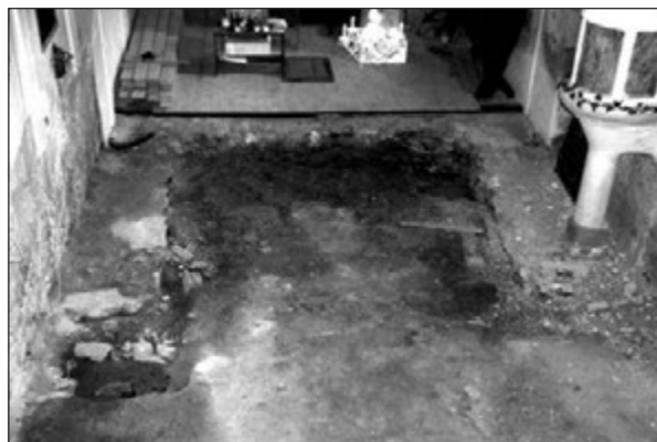
Obr. 3. Základové murivo svätyne pôvodného kostola.
