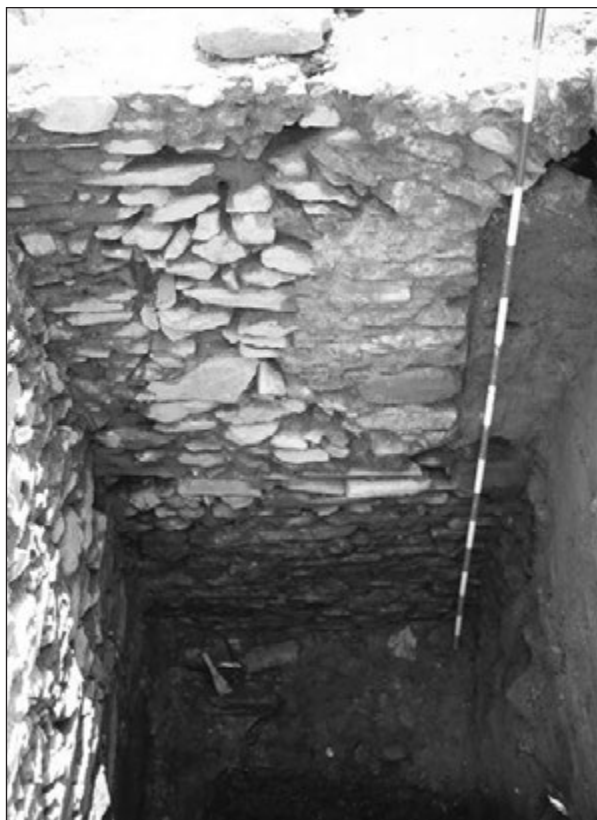
Obr. 38. Vyústenie objektu 9, fázy II v líci južnej obvodovej steny mosta (objektu 1), od S.
