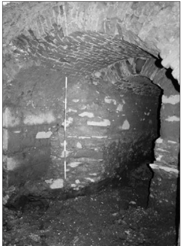
Obr. 28. Zaústenie kanála 8 do klenby západnej obvodovej steny mosta (objektu 1), od SZ.
