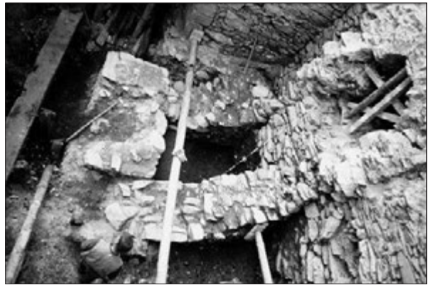
Obr. 6. Pohľad na kanál 10 v čele prebránia, od JV.
