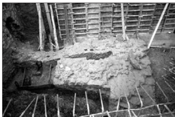
Obr. 35. Objekt 9 – fáza IV vo vonkajšej priekope v styku s objektmi 28 a 24, od Z.
