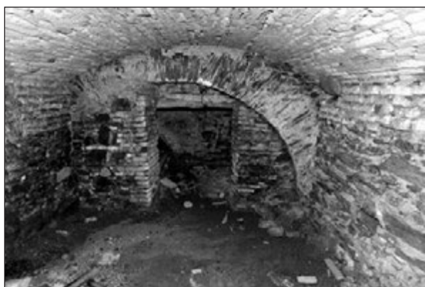
Obr. 5. Pivnica pod východným dvorovým krídlom s fylitovými stenami a s kamennými konzolami – staršieho, stredovekého, dreveného stropu – utopenými v mladšej klenbe.
