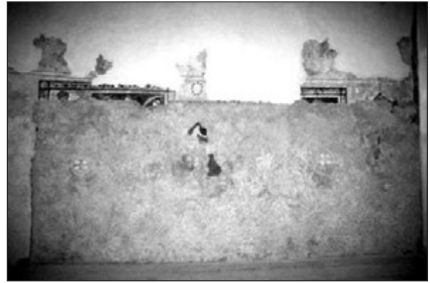
Obr. 9. Pohľad na severnú stenu stredovekej lode po reštaurovaní.
