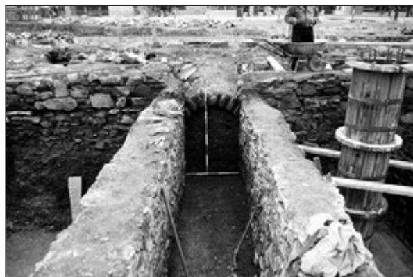
Obr. 18. Pohľad na kanál 12, od Z.
