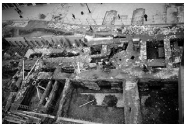
Obr. 21. Pohľad z výšky na nálezovú situáciu počas stavebných prác a realizácie výskumu, od JZ. Situácia kanálov 8, 11, 10 a 12 v stavebnom komplexe Dolnej brány.
