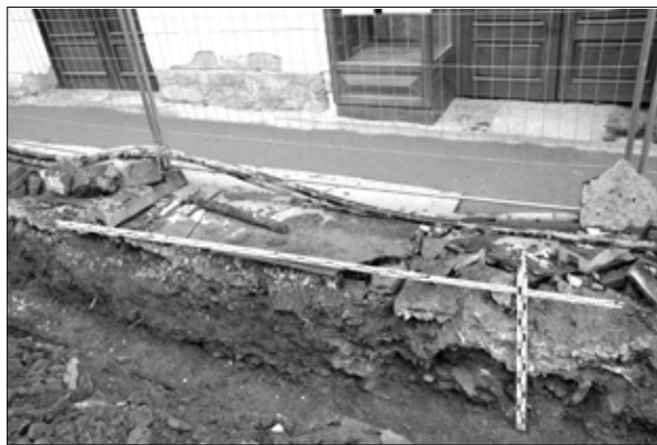
Obr. 6. Objekt 4 zachytený vo východnom profile výkopu.
