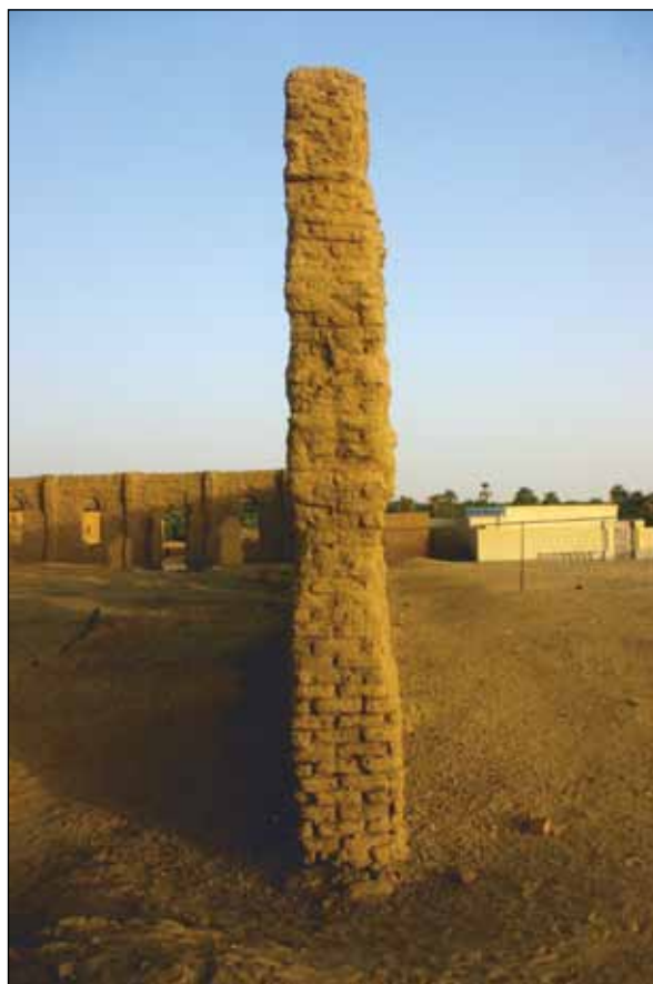
Obr. 11. Duwejm Wad Hadž. Prierez tehlovej väzby a múru v juhovýchodnom rohu mešity. Foto J. Hudec.
