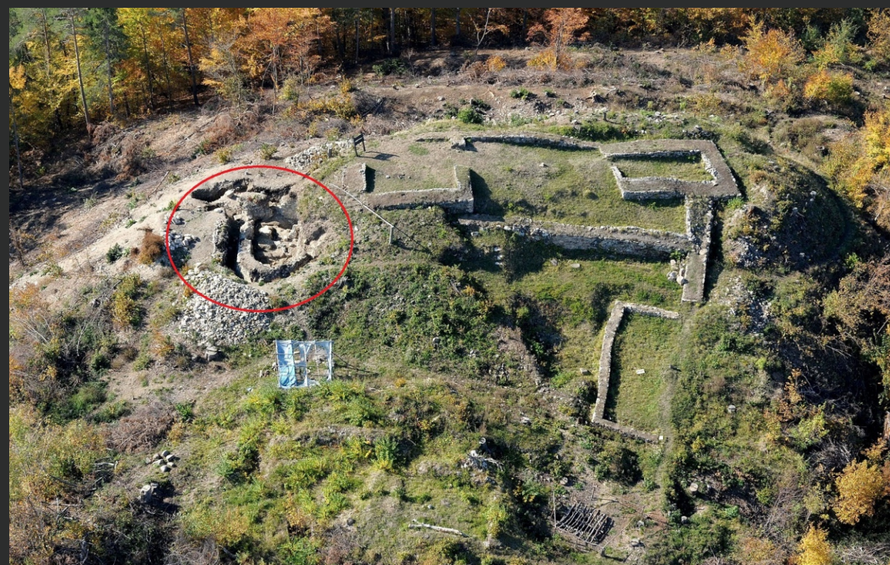
Vrcholová poloha hradu (Poloha II) s kaplnkou, vežovými a hospodárskymi stavbami, nálezmi a cisternou.
