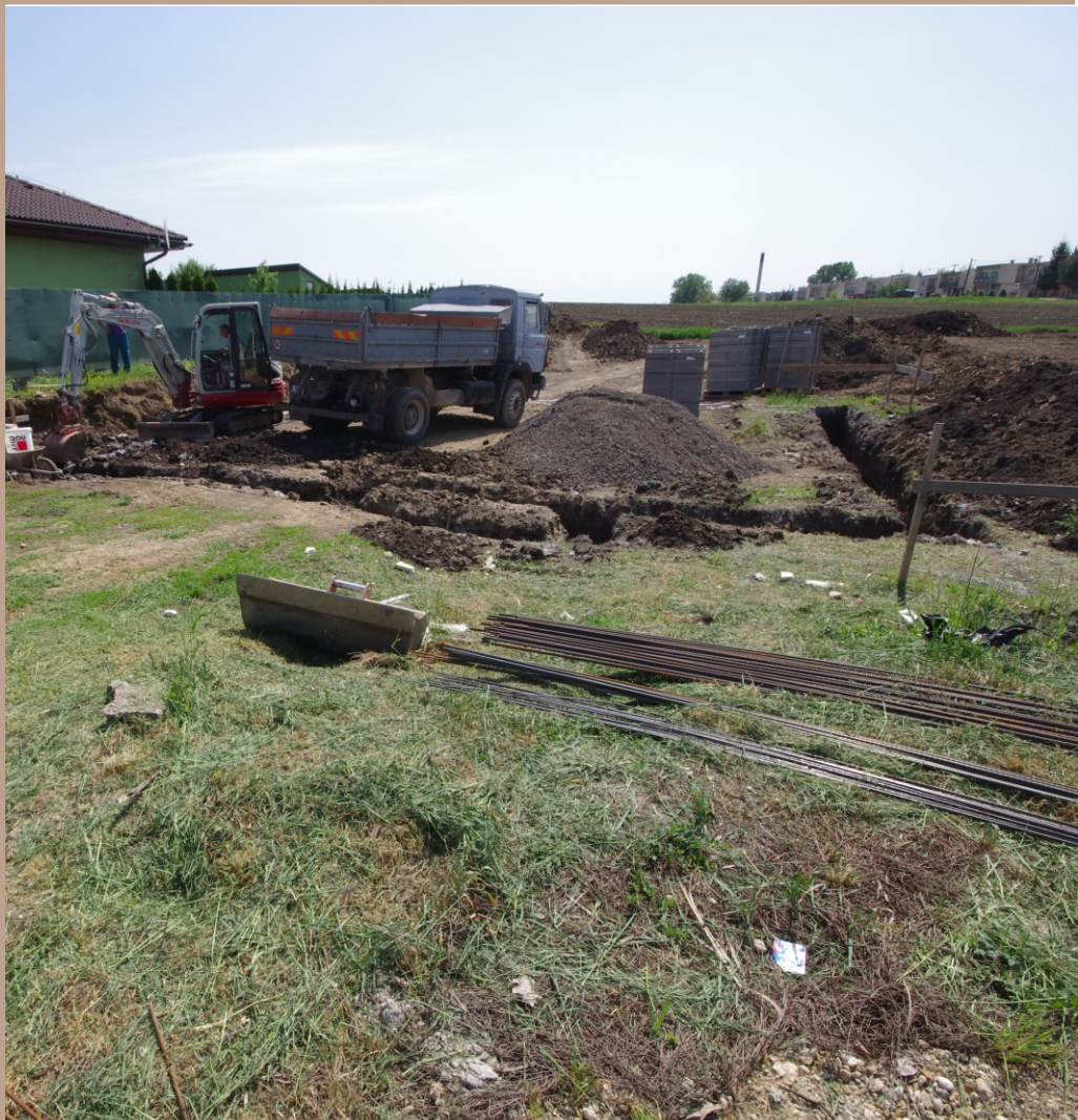
Pohľad na stavbu počas výkopových prác
