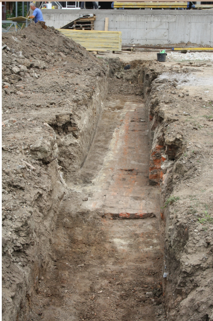
Sonda 1 so zachyteným základovým murivom
