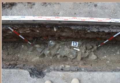
Mojmirova ulica - kamenná kanalizácia, klenba
