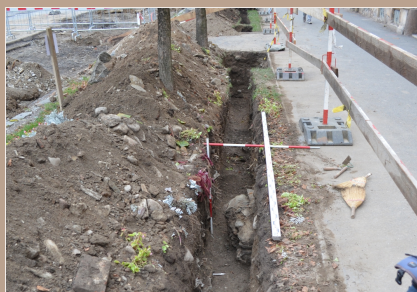
Poštová ulica, parkánová hradba mestského opevnenia porušená starším výkopom
