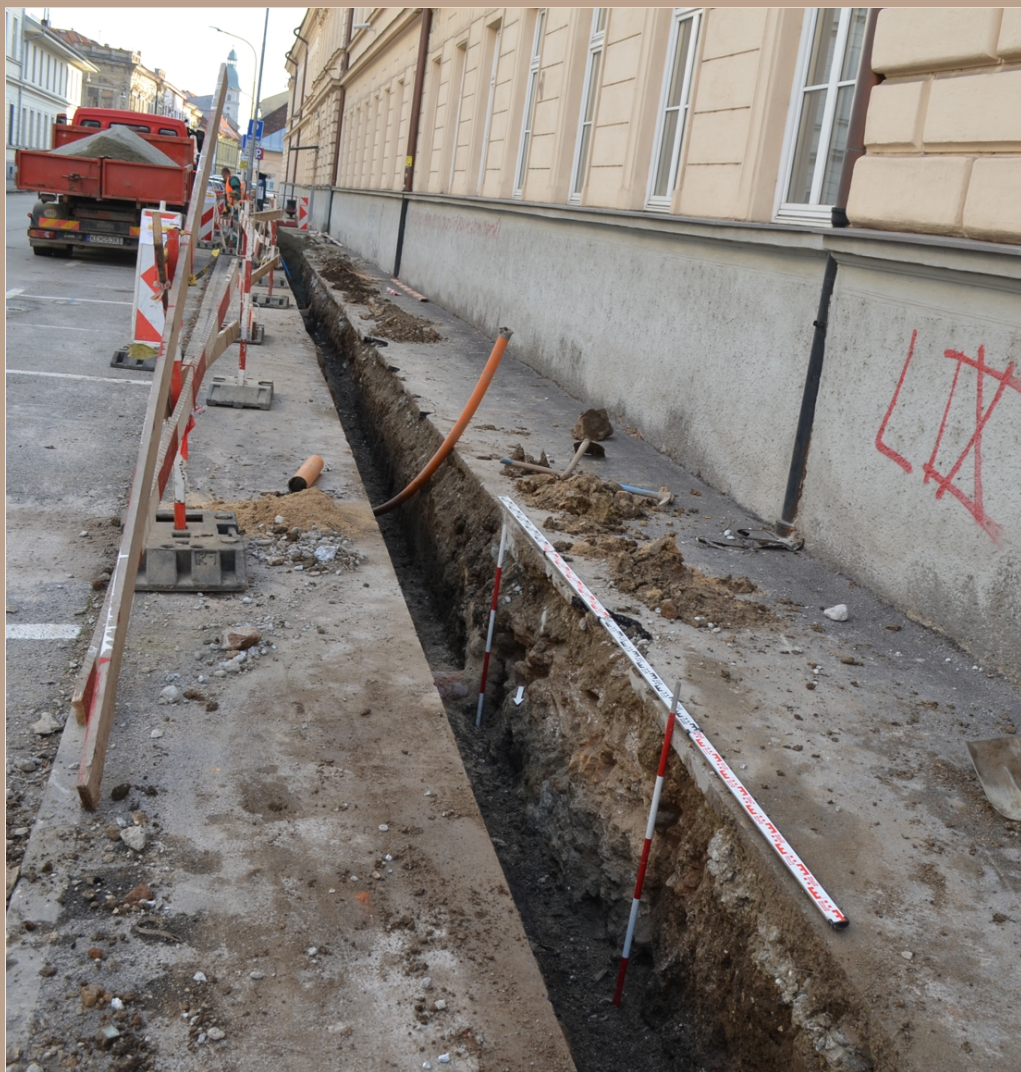
Mäsiarska ulica, výkop pre plynové potrubie, pohľad zo severu
