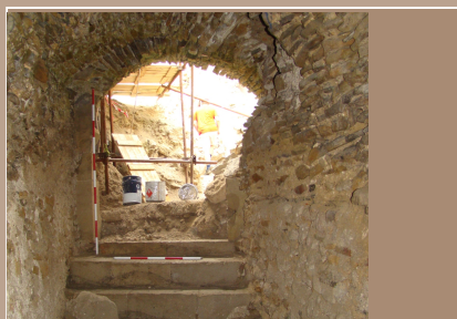
Hrad Lietava, sonda 41/2018, výskum pivnice pri Pozdĺžnej bašte. Preskúmali sme 2 kamenné schody v interiéri a kamenný prah.
