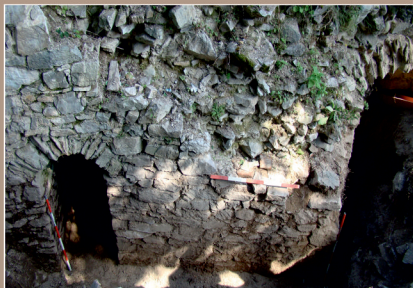
Hrad Gýmeš, sonda 9B/2020, zachytená chodba s výlevkou v renesančnej delovej bašte
