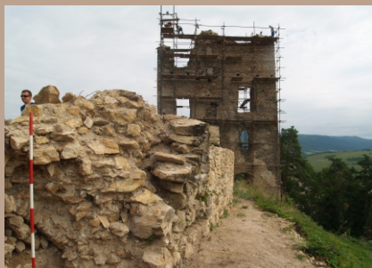
Predhradie - odkrytý východný múr opevnenia predhradia, rekonštrukcia SV bašty
