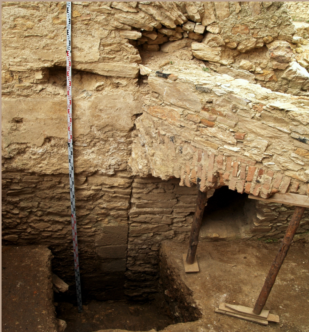
Horný Hrad - južný palác - sonda 3d6/An - východná špaleta pôvodnej gotickej brány v plášťovej hradbe, zamurovanie vstupu a prerazenie kanalizačného otvoru
