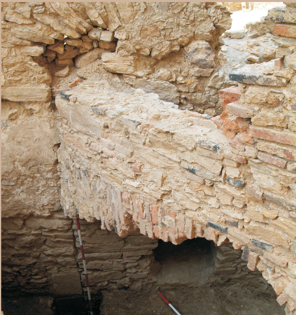
Hrad - Divín (zamurovaný pôvodný gotický vstup s kanalizačným otvorom a mladšou priečkou na nosnom oblúku - priestor južného paláca - sondy 3d6, 3e)
