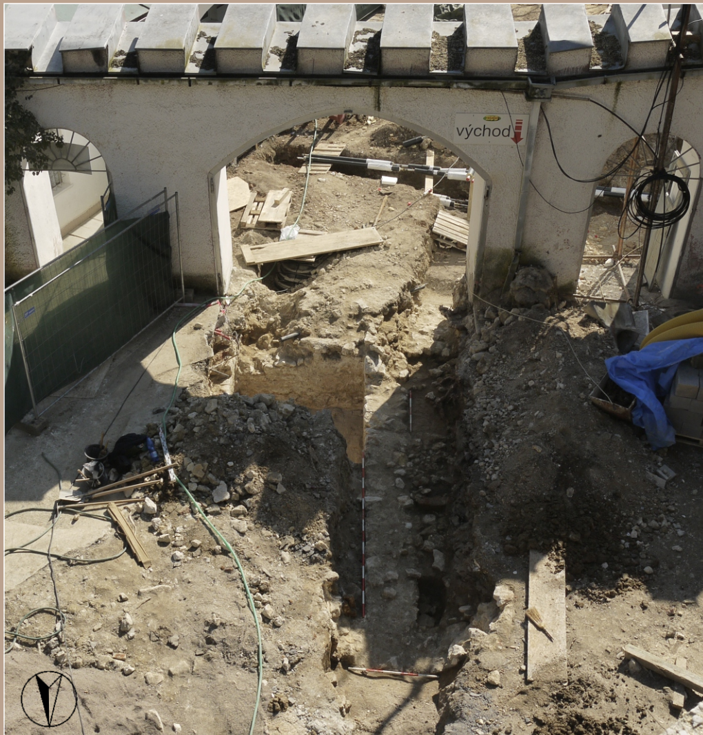
Základy murovanej stavby a odkrytá časť severozápadného nárožia mestského opevnenia
