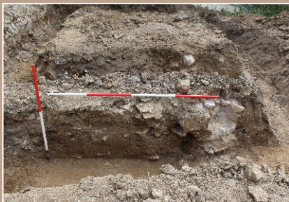
Základový múr a zvyšok zničenej nadzemnej časti
