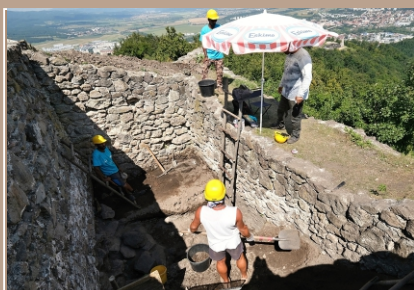
Sonda 5/2020 v interiéri veže vo vých. línií opevnenia Horného hradu
