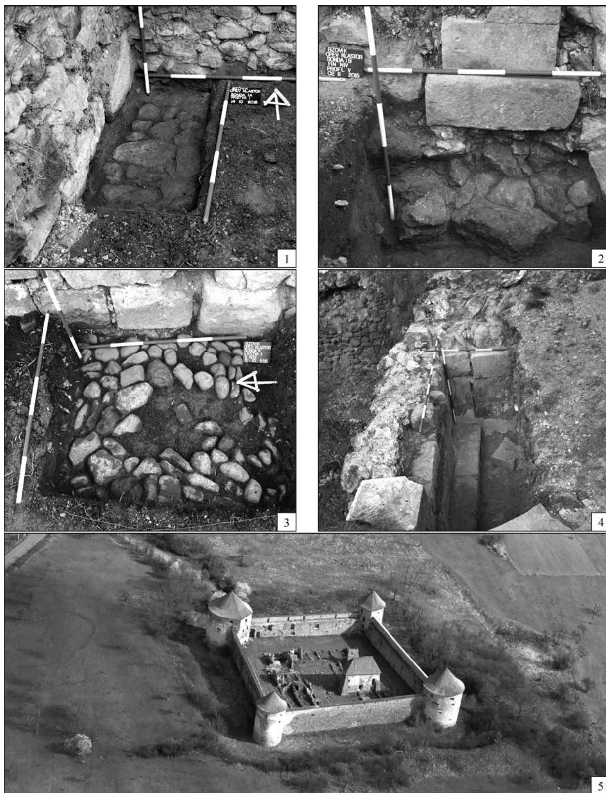
Obr. 12. Bzovík (kláštor premonštrátov). 1, 3 – odkrytá kamenná podlaha v sonde 1A a 1C/2015; 2 – základové murivo v sonde 1B/2015; 4 – sonda 2A/2015, odkryté murivo; 5 – letecký pohľad na objekt z juhu (foto J. Beljak). (Beljak/Debnár/Cheben, 27). Abb. 12. Bzovík (Prämonstratenserkloster). 1 und 3 – freigestellter steinerner Boden im Schnitt 1A und 1C/2015; 2 – Grundmauerwerk im Schnitt 1B/2015; 4 – Schnitt 2A/2015, aufgedecktes Mauerwerk; 5 – Luftansicht auf das Objekt von Süden (Foto J. Beljak). (Beljak/Debnár/Cheben, 27).
