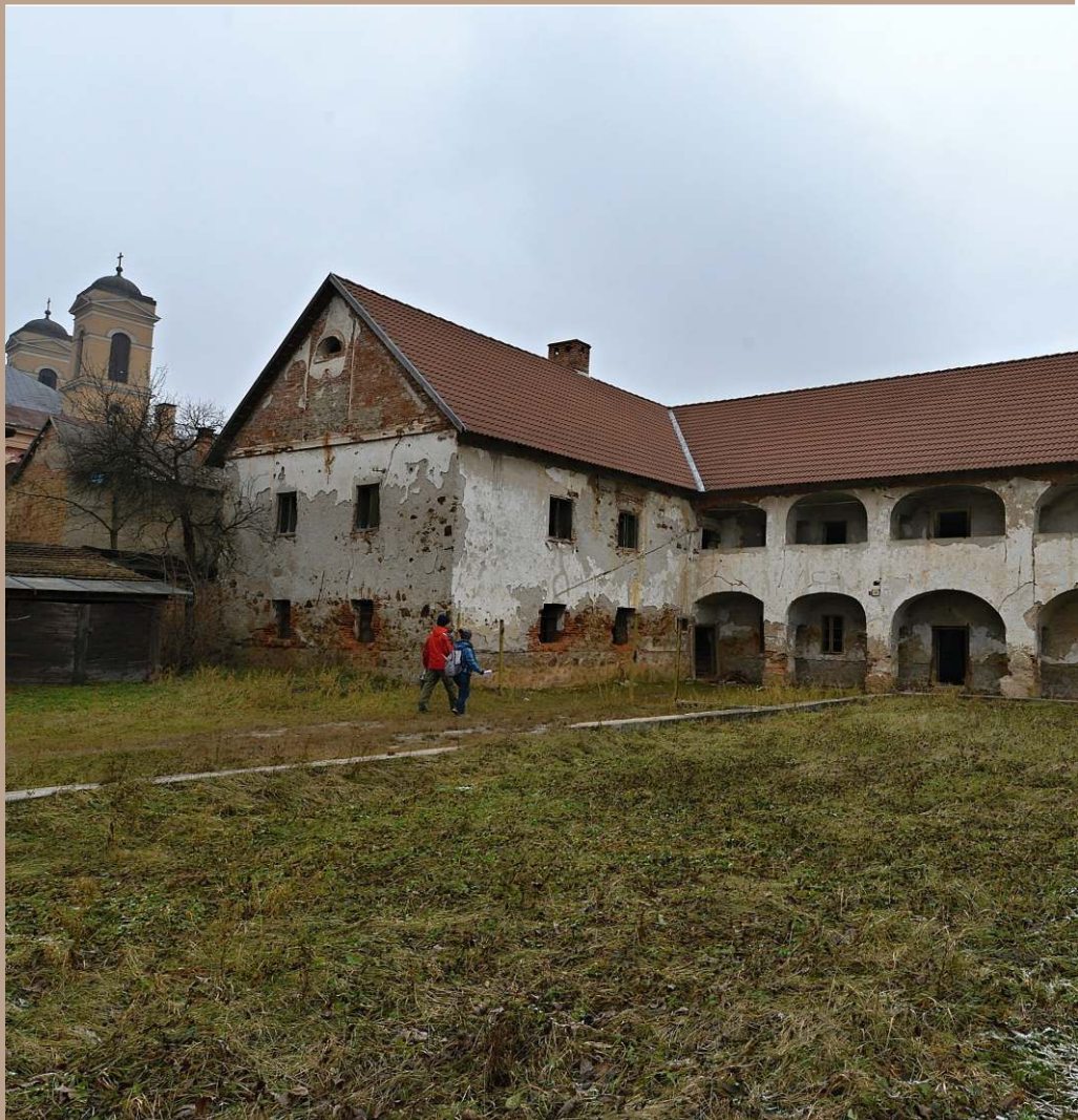
Jelšava - pohľad na objekt NKP škola ev. a. v. z juhozápadu
