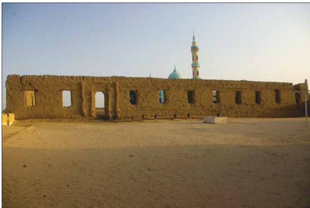
Obr. 9. Duwejm Wad Hadž. Zachovaná severná stena starej mešity. Foto J. Hudec.
