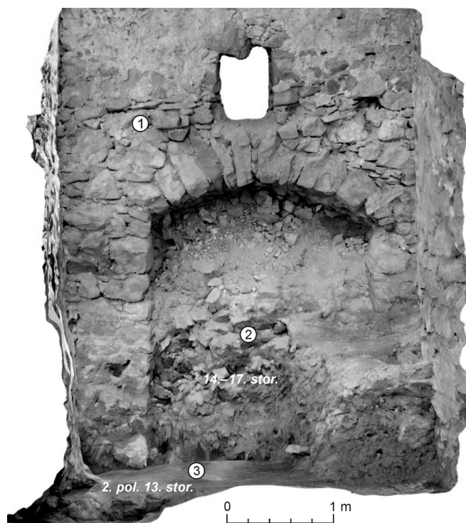
Obr. 24. Oponický hrad. Sonda 8/2016. Severný profil – dverný otvor v severnom múre juhovýchodného paláca I. 1 – murivo; 2 – vrstva sute; 3 – hlinitá až hlinito-maltová podlaha. Foto a spracovanie M. Styk.
