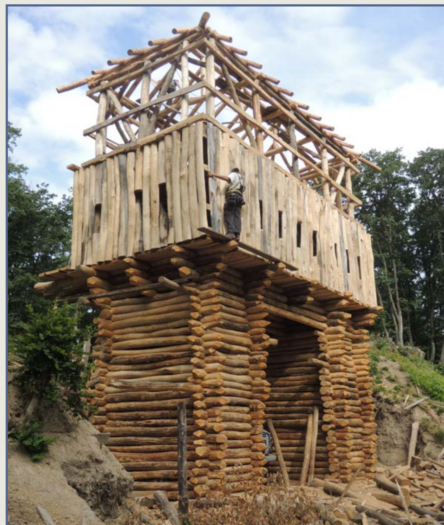
BRÁNA V PRIEBEHU VÝSTAVBY
