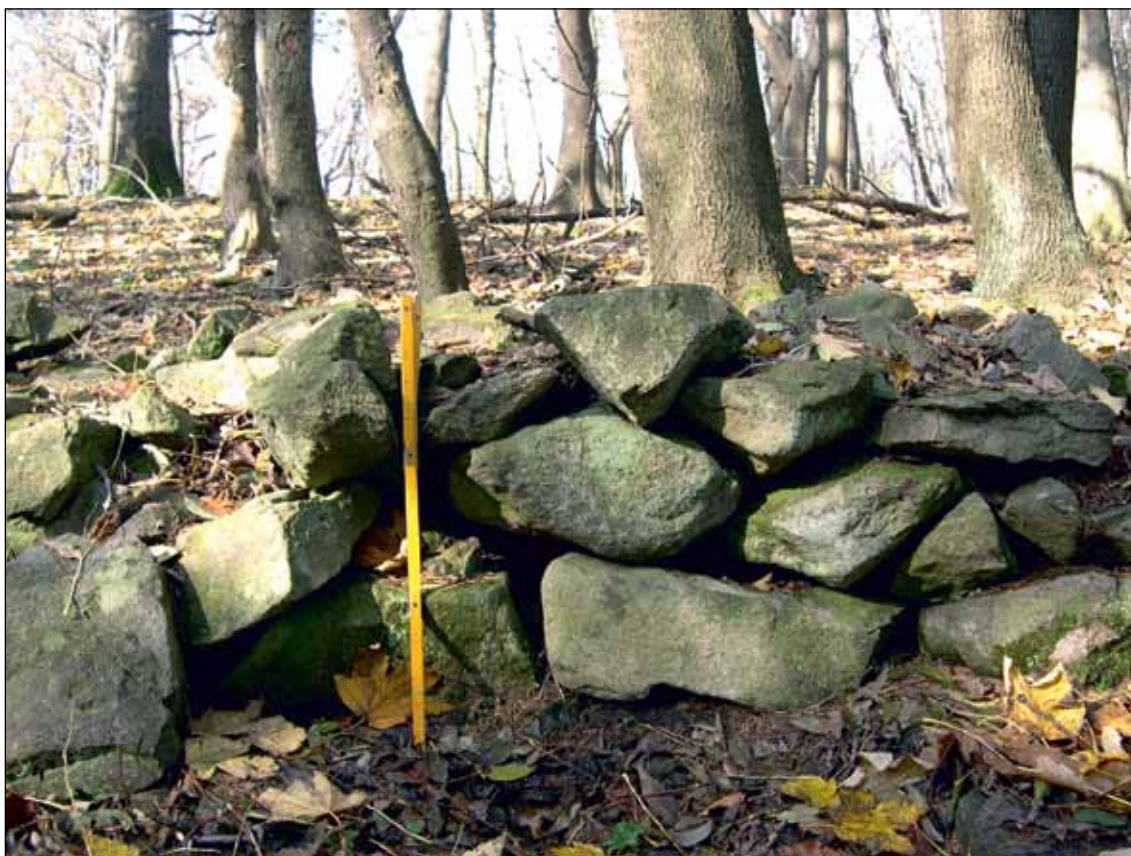
Obr. 8. Veľký Tribeč. Obvodový múr objektu z nasucho kladených kameňov na hradisku. Stav z roku 2004. Foto P. Bisták.
