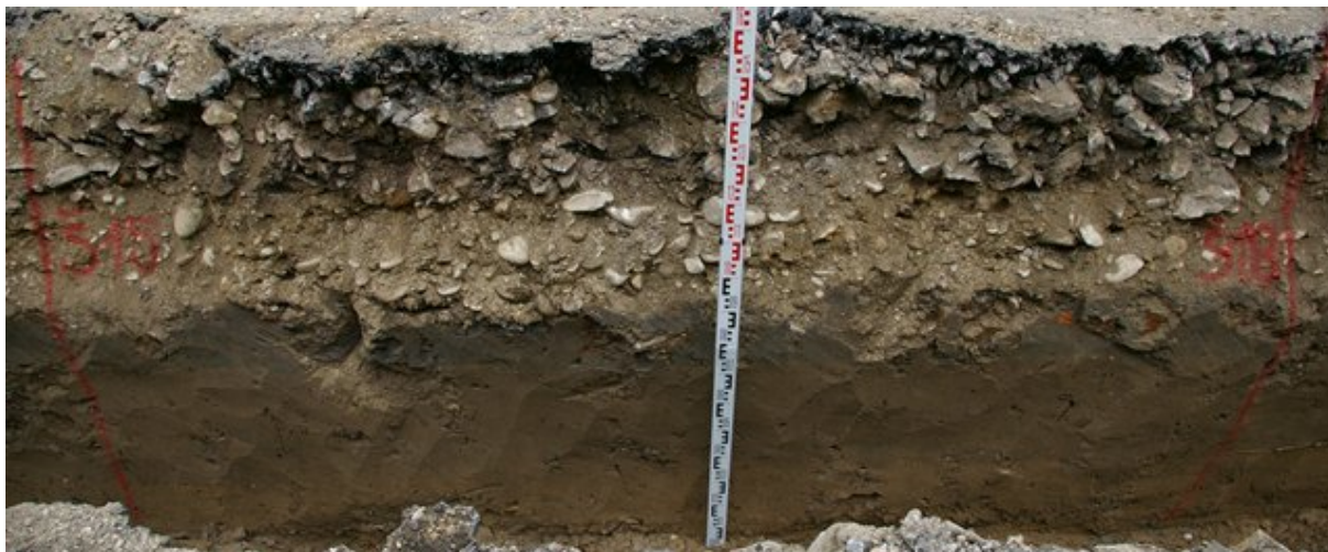
Obr. 02. Zvolen, ul. M. R. Štefánika. Detail na východný profil vodovodnej ryhy.
